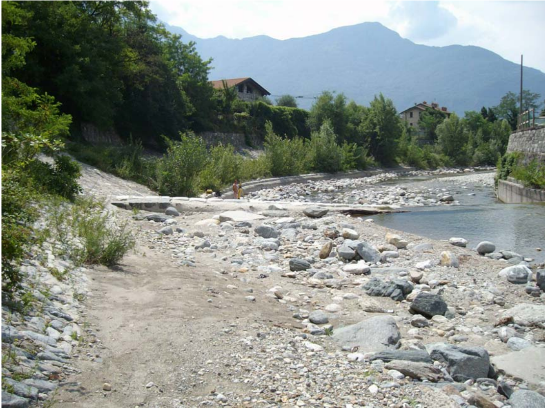
Foto 7 – Soglia n.4 (vista da monte verso valle)
