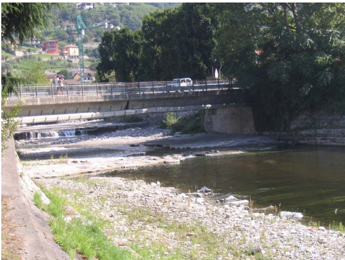
Foto 2 – Ponte della S.S.Regina (vista da valle verso monte)
