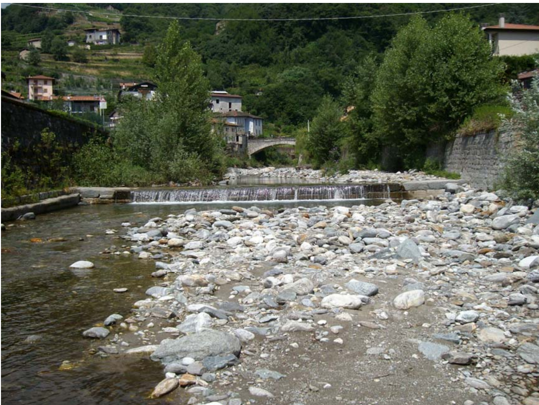
Foto 8 – Soglia n.5 (vista da valle verso monte)
