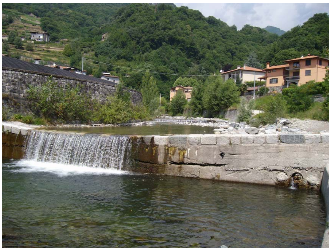
Foto 6 – Soglia n.4 (vista da valle verso monte)
