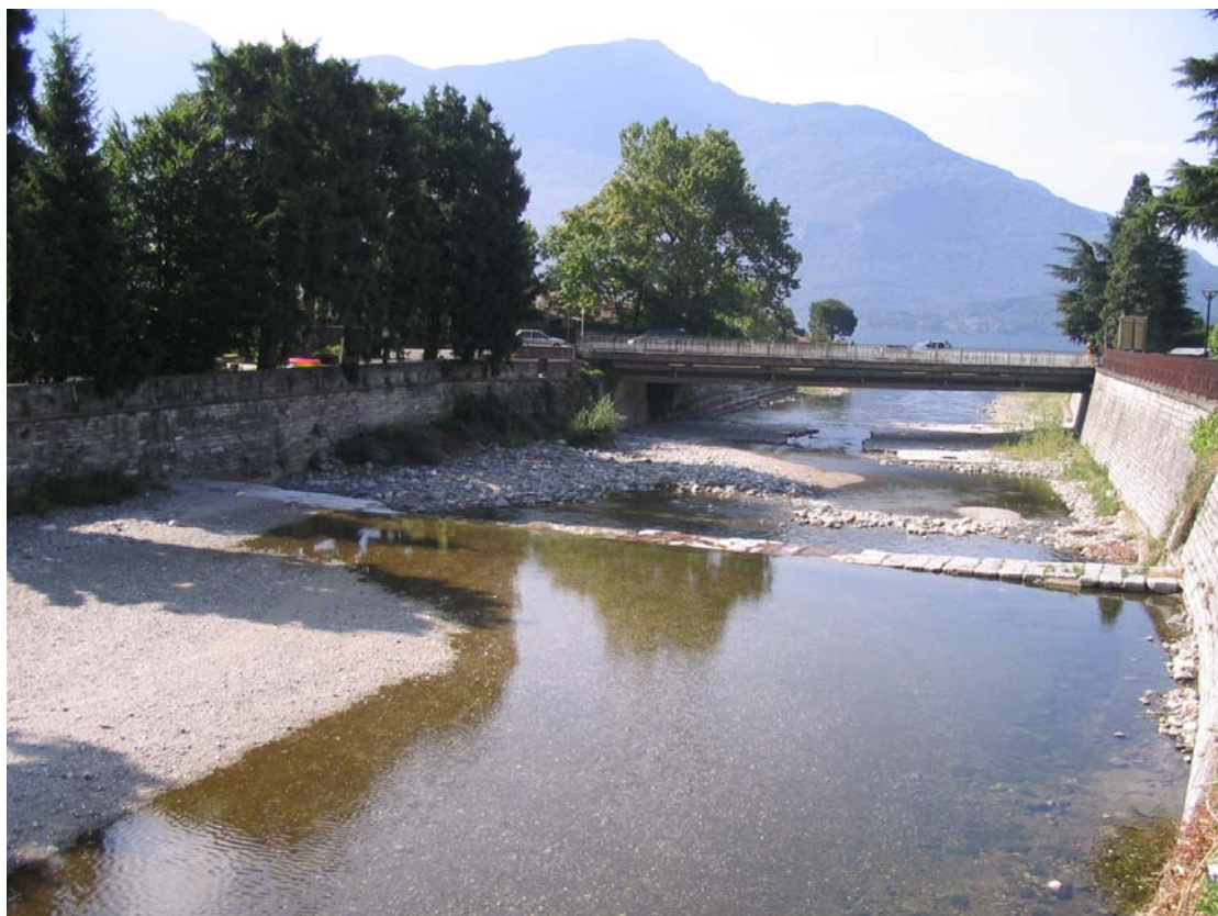
Foto 3 – Ponte della S.S.Regina (vista da monte verso valle)
